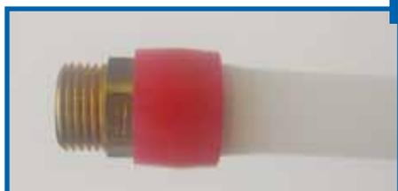
**5** Inserte totalmente el accesorio en la tubería. Si no puede insertar el accesorio en la tubería, retire el accesorio y expanda una vez más.
