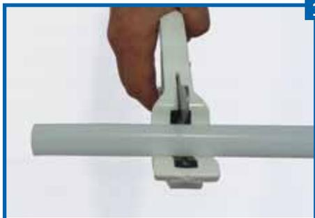
Para conseguir un buen resultado, es imprescindible cortar el tubo de manera limpia y perpendicular a su eje. El extremo de la tubería deberá estar seco y sin lubricante, de este modo, el anillo de plástico no se deslizará por la tubería al expandirla.
